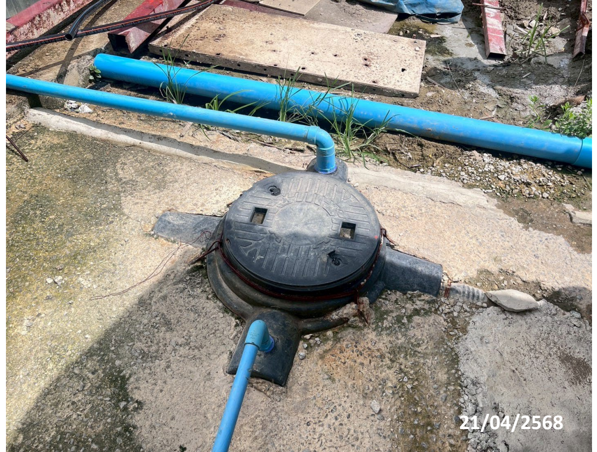
4. ตรวจสอบน้ำทิ้งจากห้องน้ำให้มีการบำบัดก่อนปล่อยออก นอกโครงการ
