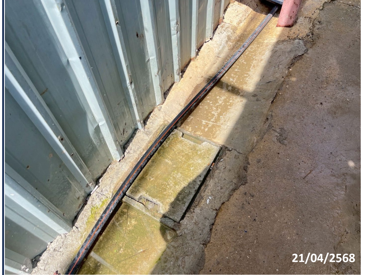
2. ตรวจสอบวางระบายน้ำรอบโครงการ
